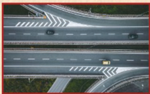
రోడ్ల నిర్మాణం/విస్తరణ (10 ప్రాజెక్టులు) రూ. 4,593 కోట్లు
